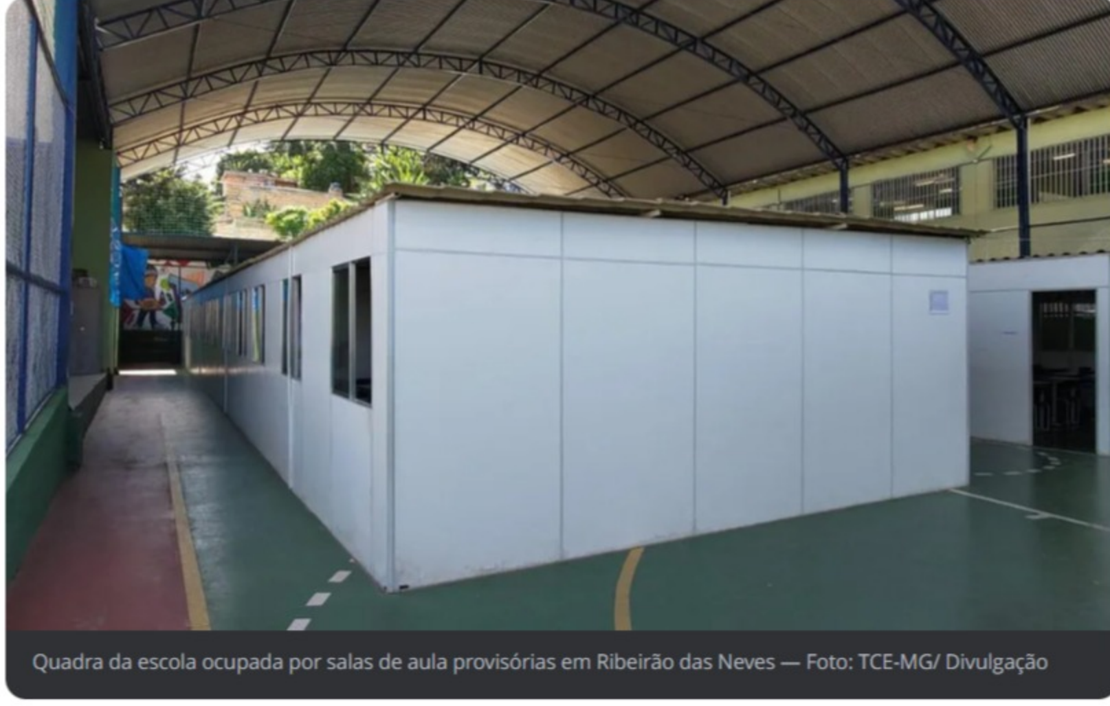
Quadra da escola ocupada por salas de aula provisórias em Ribeirão das Neves — Foto: TCE-MG/ Divulgação
