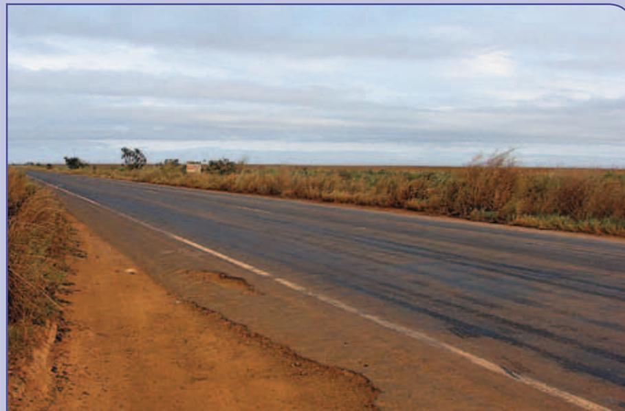
Panela no acostamento e revestimento desgastado
