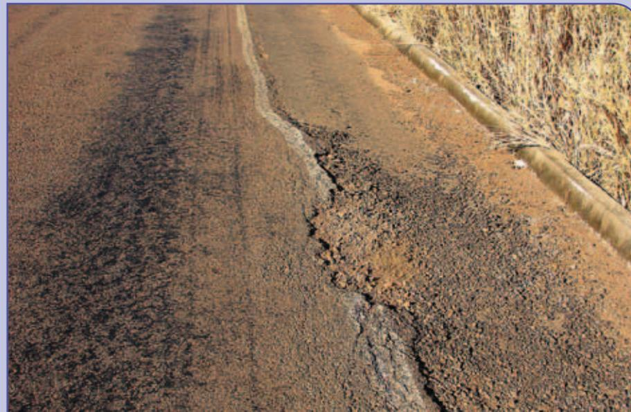
Afundamento, revestimento desgastado, panela no bordo da pista e acostamento
