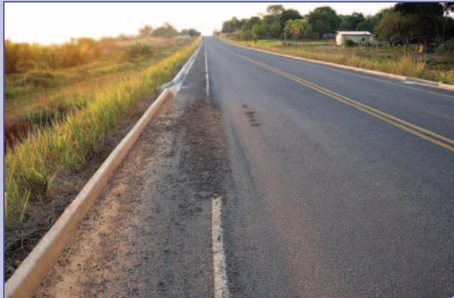
Afundamento com perda de agregado
