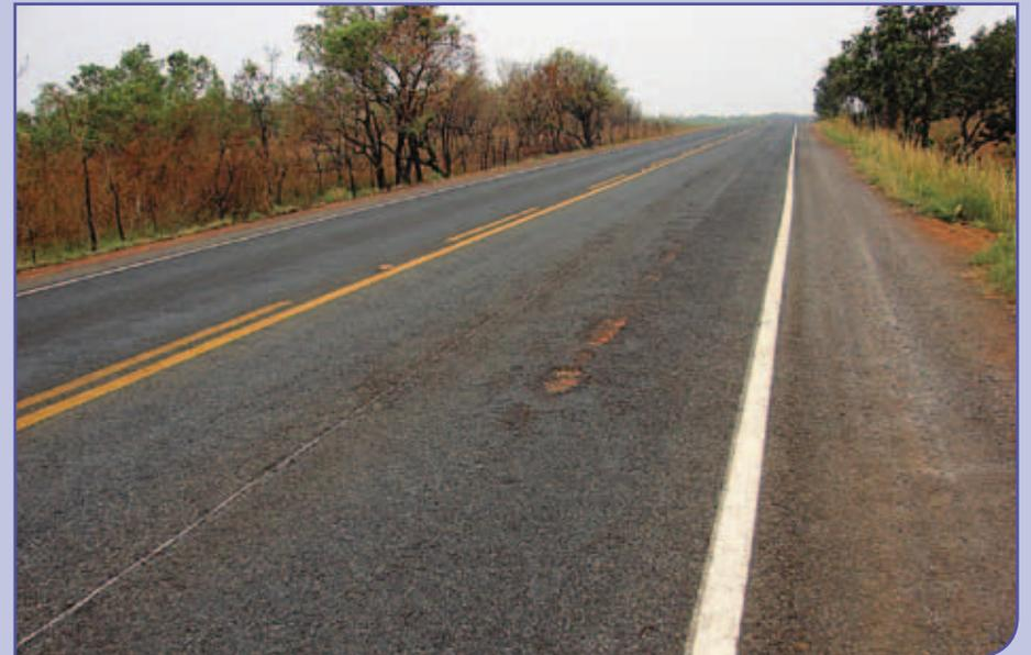
Revestimento desgastado e panelas
