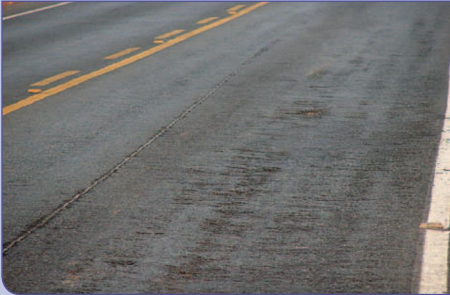
Revestimento desgastado e panelas
