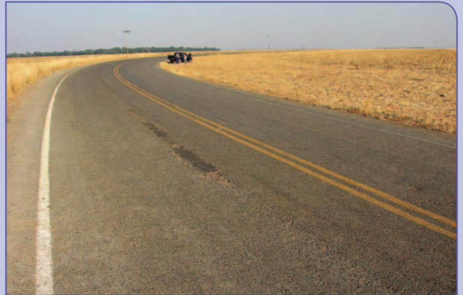
Revestimento desgastado e panela
