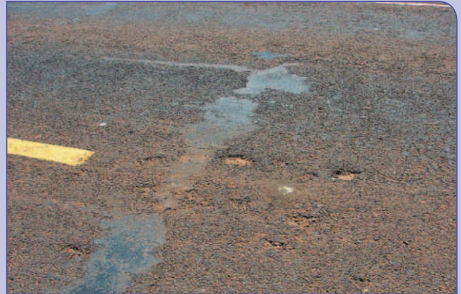
Panelas e revestimento desgastado
