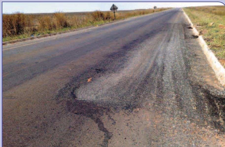
Remendo com afundamento e panelas
