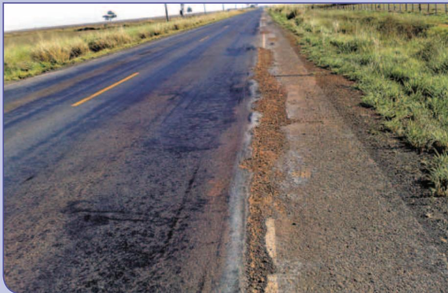
Afundamento e revestimento desgastado com panela
