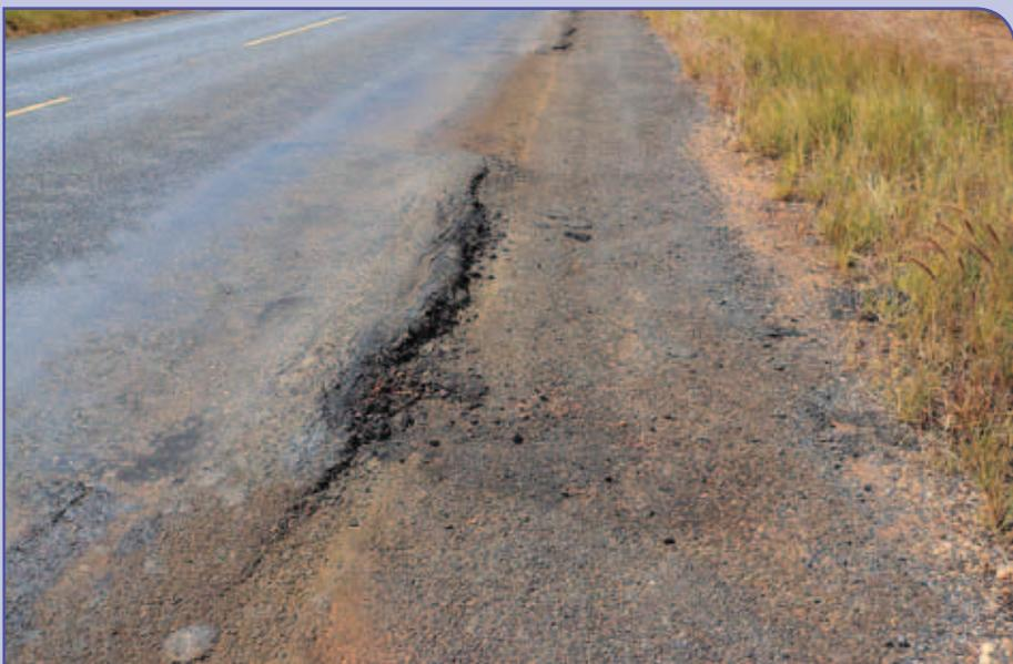
Afundamento com perda de agregado
