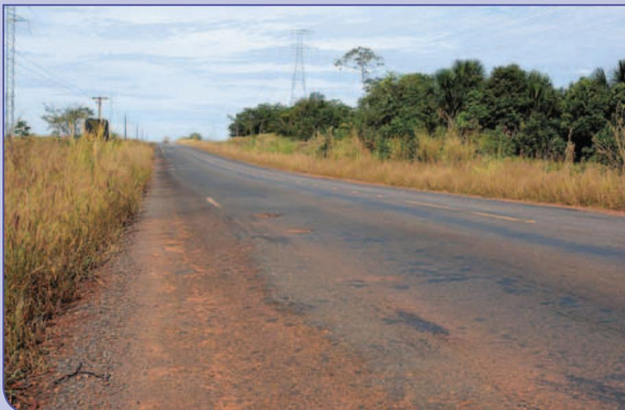
Revestimento desgastado com panelas
