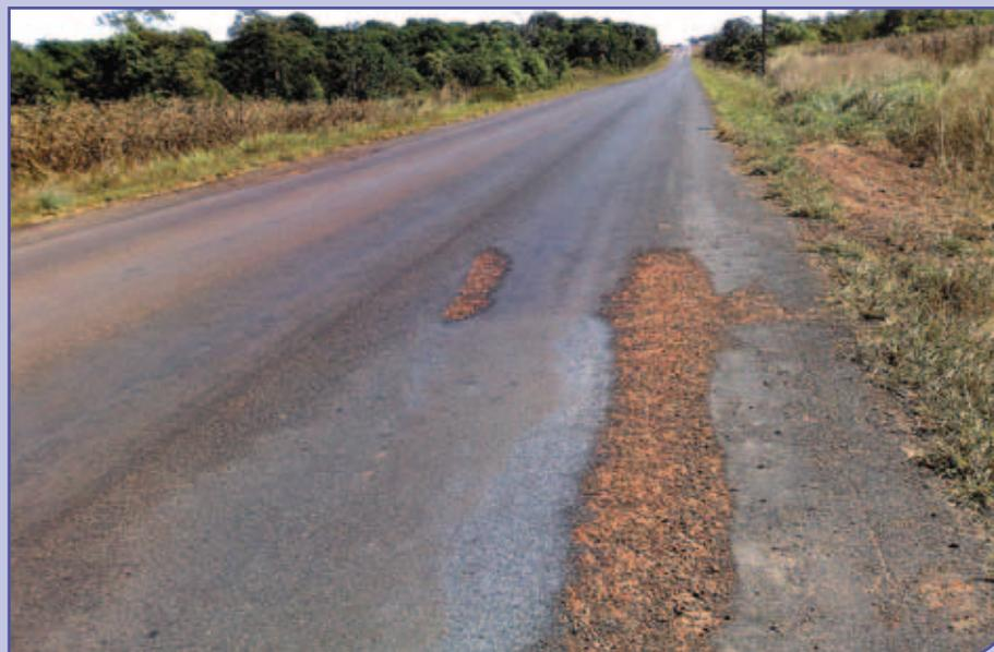
Panela e revestimento desgastado na pista e acostamento
