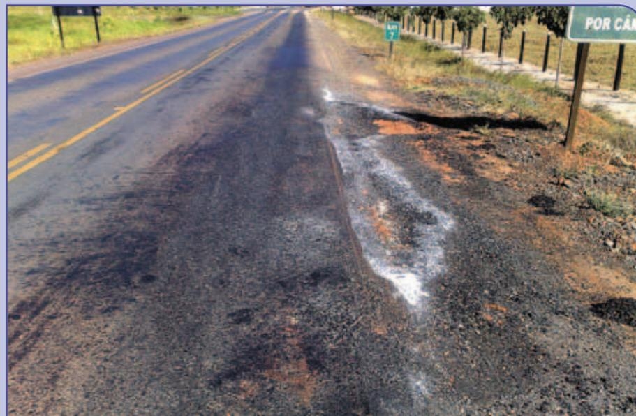
Perda de agregado, afundamento, remendo e panela
