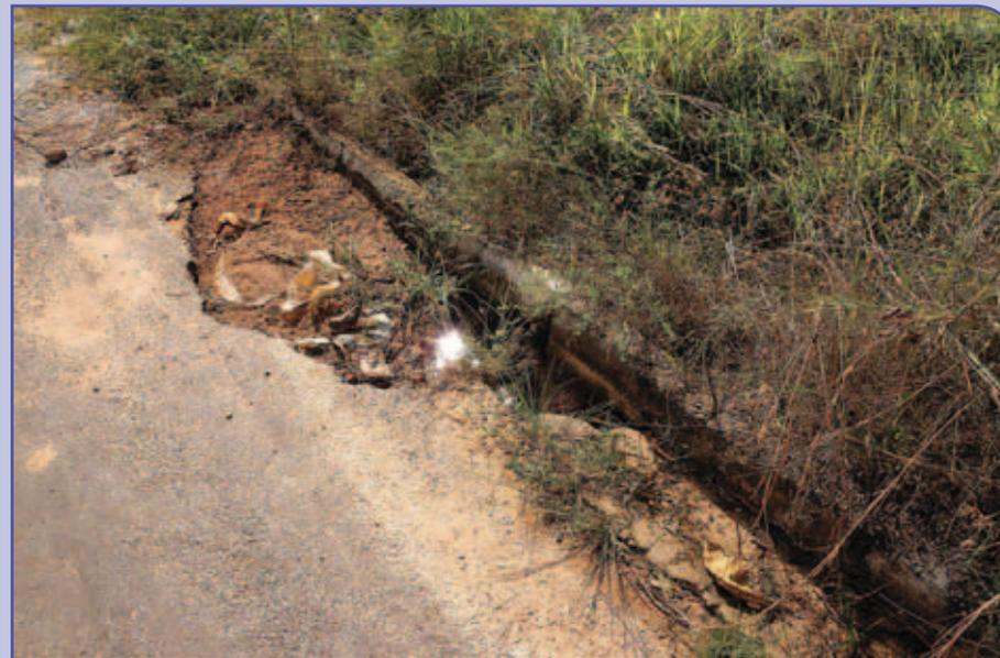
Panela, afundamento e dispositivo de drenagem danificado
