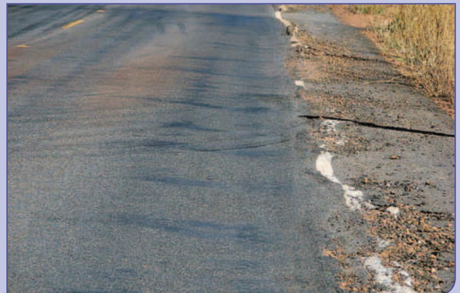
Bordo com afundamento e acostamento com panelas e desgaste
