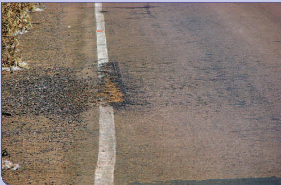
Panela no bordo da pista e revestimento desgastado no acostamento
