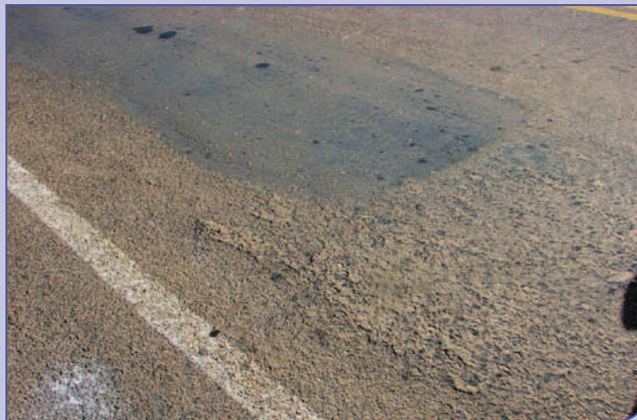
Remendo e revestimento desgastado
