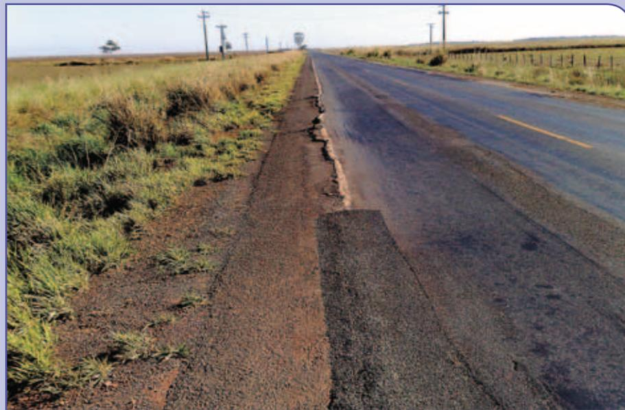
Remendo e afundamento
