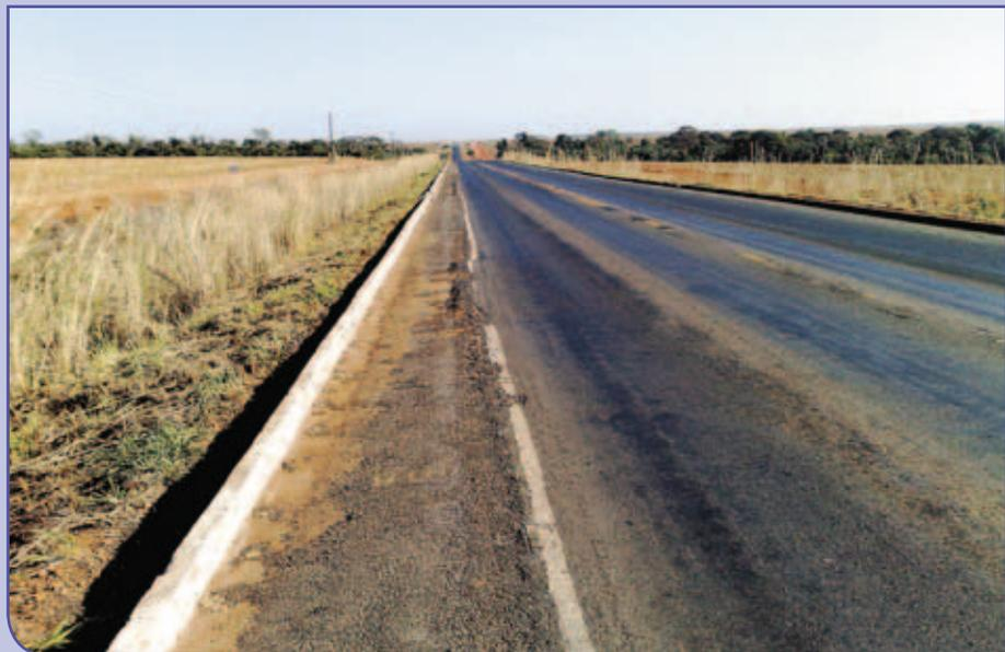
Trilha de rodas e revestimento desgastado com panelas no acostamento
