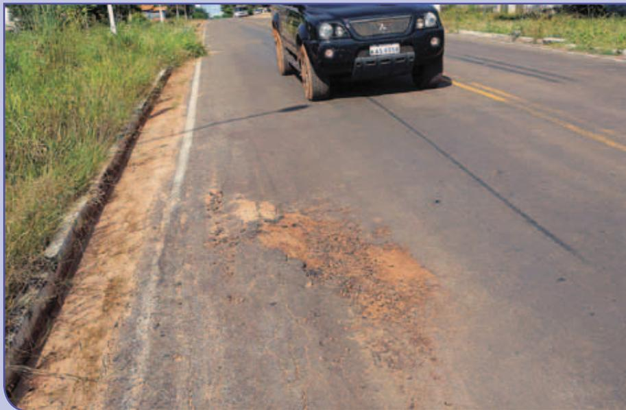
Panela com afundamento
