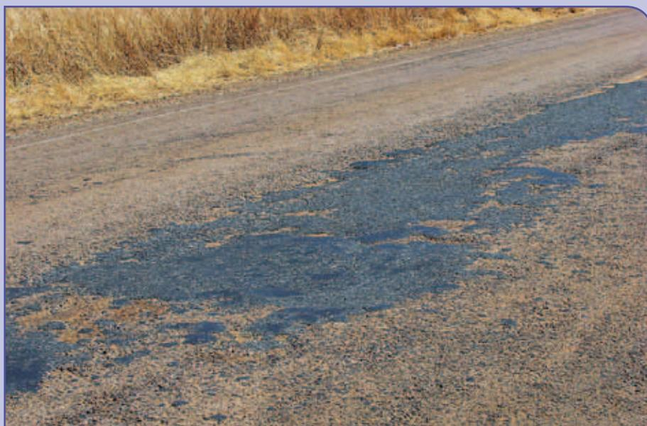
Revestimento desgastado e remendo
