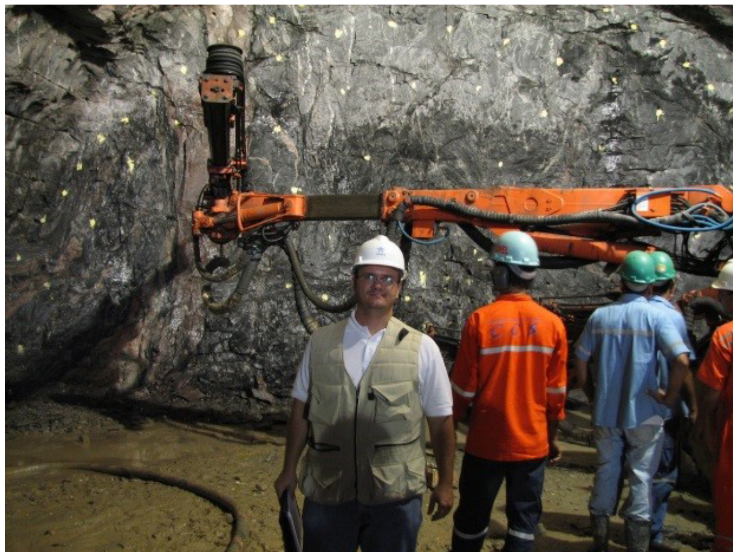
Figura 16. Perfuração precisa com o uso de “jumbo” para colocação dos explosivos no túnel
