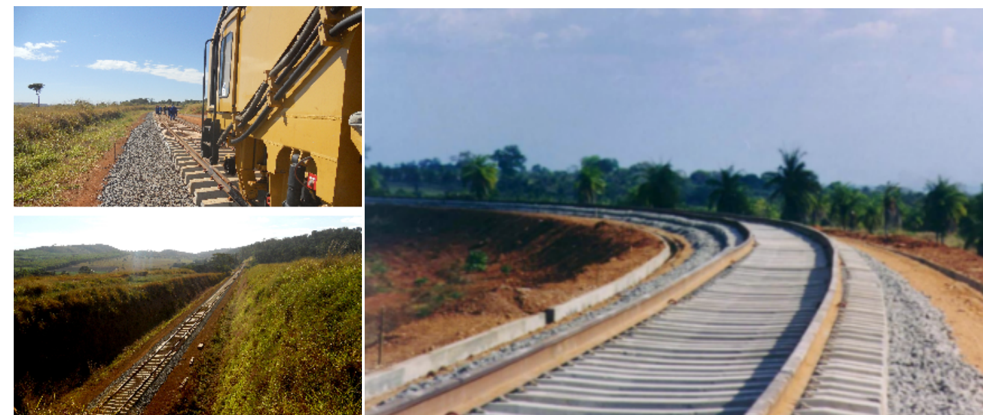
Figura 41. Construção da Ferrovia de Integração Oeste-Leste - Caetité-Barreiras (BA)
