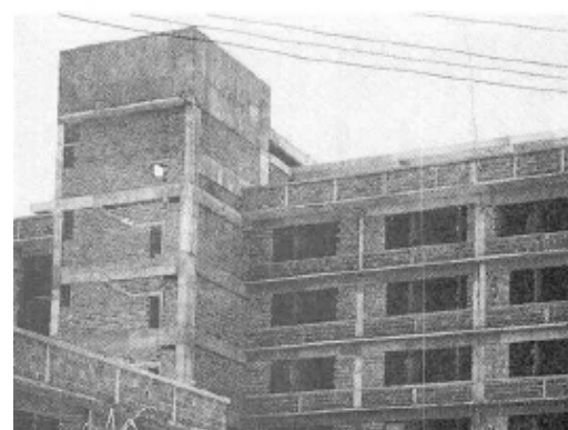
Obra: Pronto Socorro de Venda Nova (MG)
