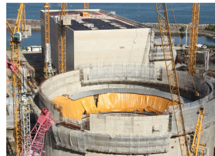
Figura 32. Angra 3, edifício do reator
