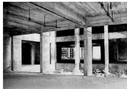
Obra: Prédio da Justiça Estadual, em Manaus (AM)
