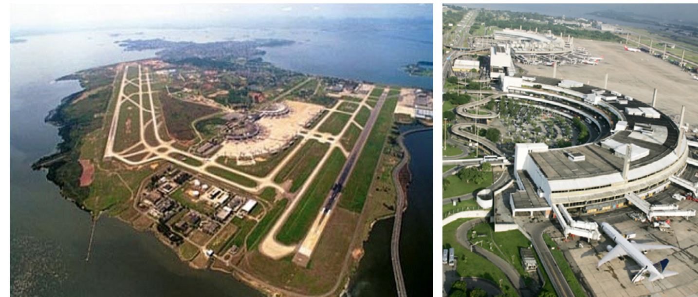
Figura 43. Revitalização e modernização do Aeroporto Internacional do Galeão (RJ)
