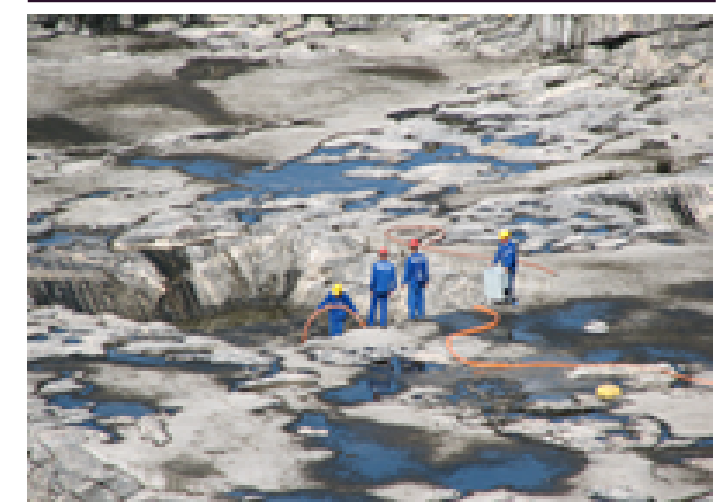
Figura 35. Angra 3, esgotamento da cava
