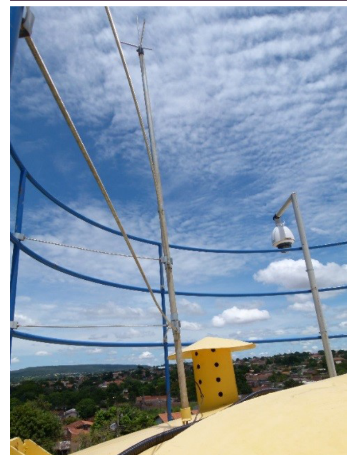
Figura 29. Alto da caixa d'água em obra em Anápolis (GO)
