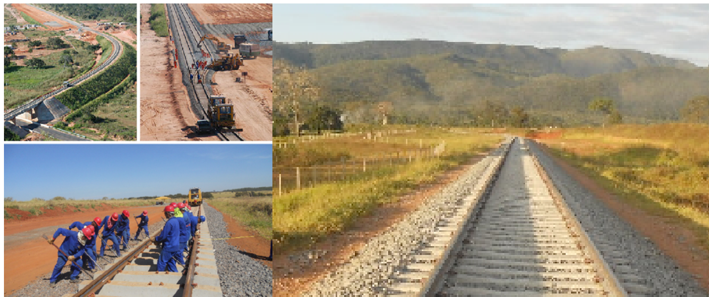
Figura 42. Construção da Ferrovia Norte-Sul – Ouro Verde de Goiás-São Simão (GO)
