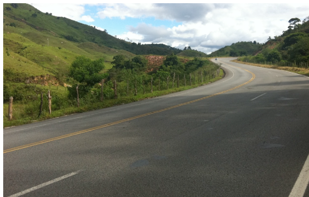
Figura 55. Obras de duplicação da BR-381 (MG) – Lote 3.1
