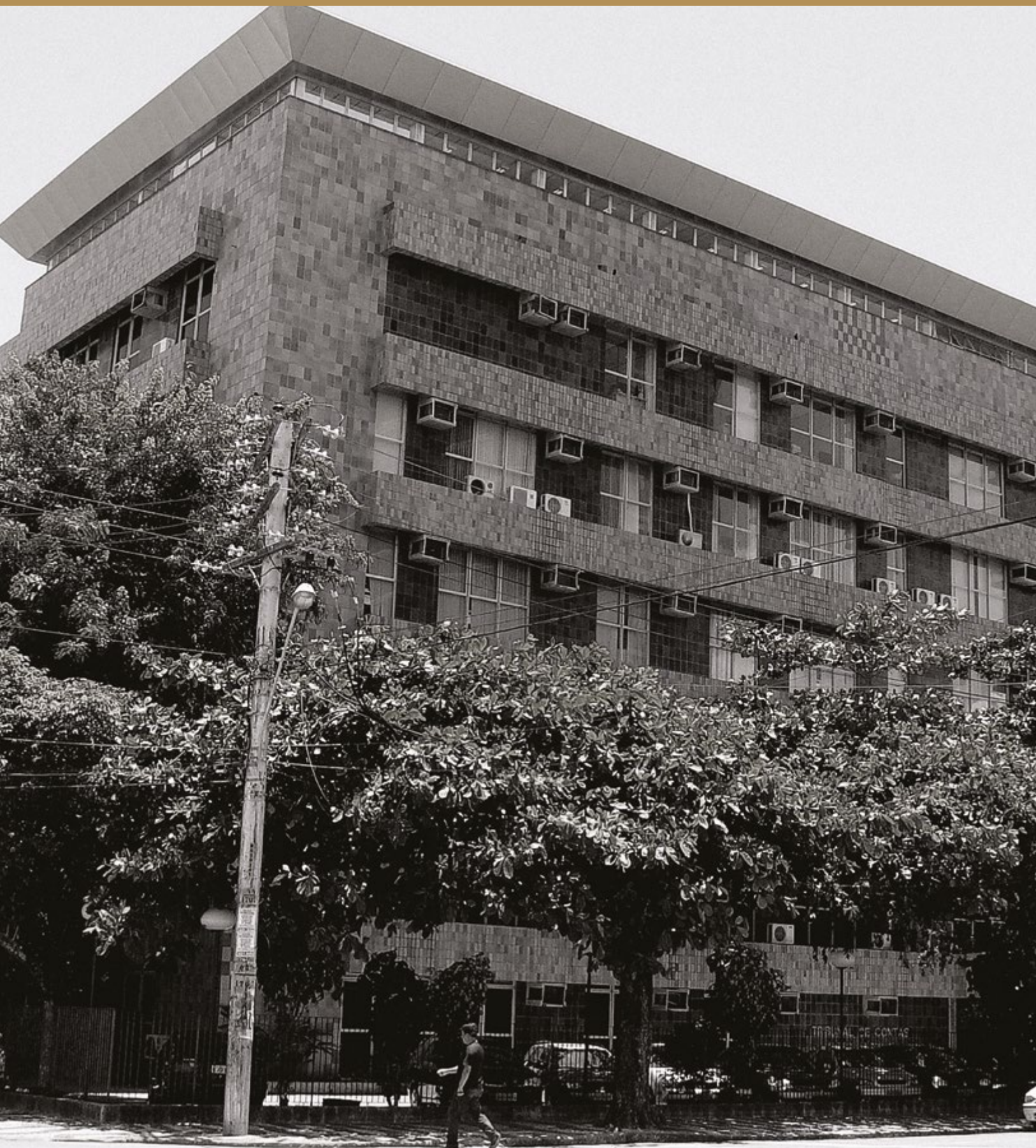
Edifício Nilo Coelho. Fonte: acervo TCE-PE.
