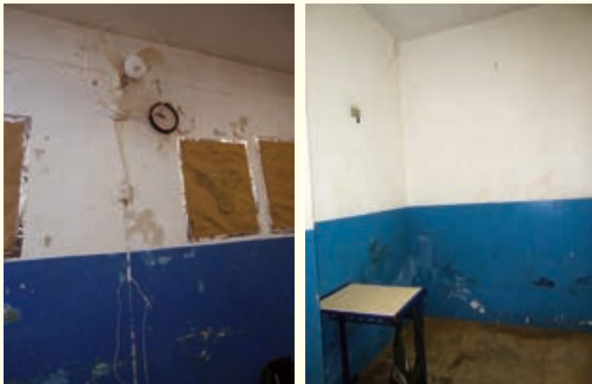
Condições de conservação das salas de aula
