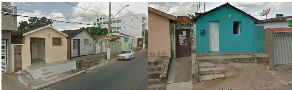
FIGURA 9 – CASAS COM DIFICULDADE DE ACESSIBILIDADE E CONSTRUÇÃO IRREGULAR
