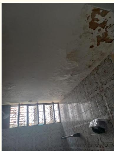
**Figura 10 Natal/RN. Conselho Tutelar Região Oeste. Detalhe do teto com infiltração e mofo.**
