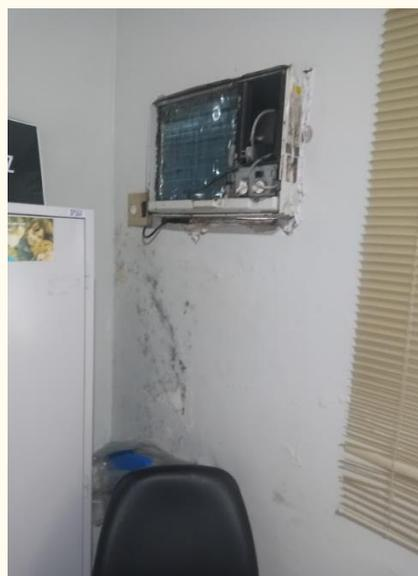
**Figura 12 Belém/PA. Conselho Tutelar VII. Sala do conselheiro com infiltração**
