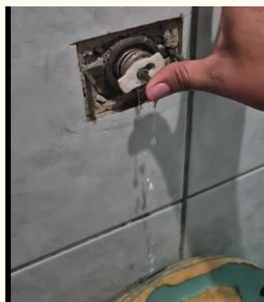
**Figura 15 CT - Cuiabá/MT. 3º Conselho Tutelar de Cuiabá. Detalhe do vazamento na descarga do banheiro.**
